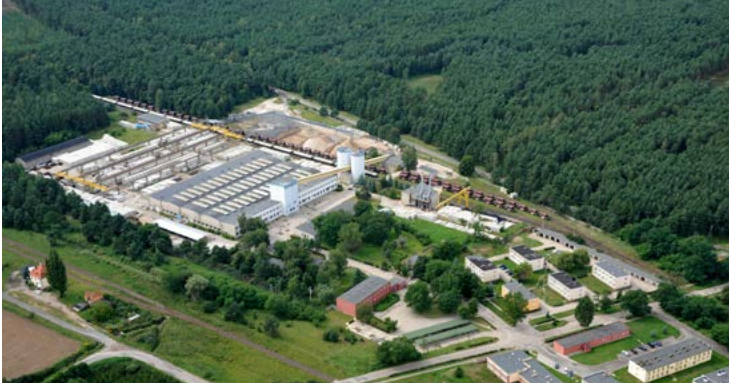
Wytwórnia Podkładów Strunobetonowych
